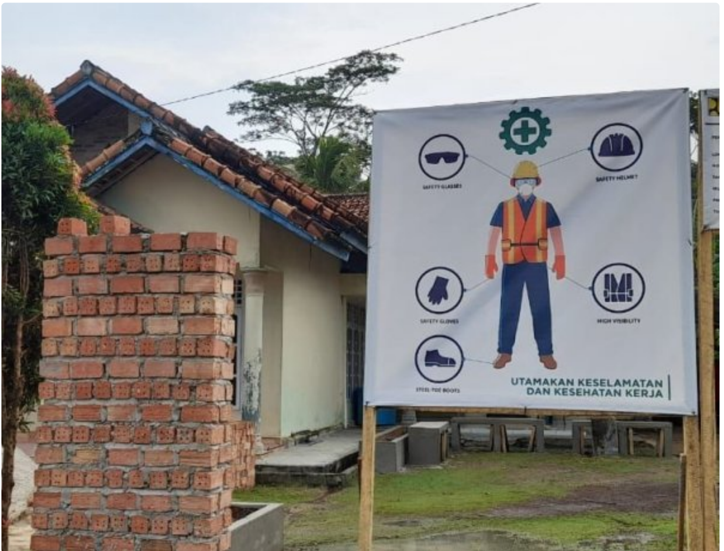
Proyek Infrastruktur Hunian Hijau di Mesuji
