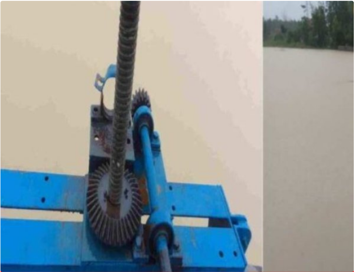
Pintu air Albaret Simpang Mesuji
